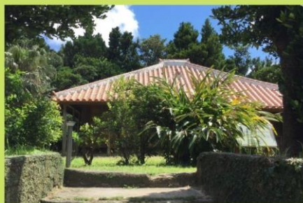
令和元年度久米島町空き家調査からの
