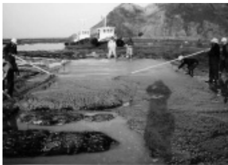
岩ノリ養殖場の補修整備(飛島)。
