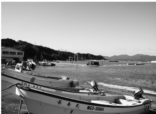
港全体がため池のようになってしまった長渡漁港。
