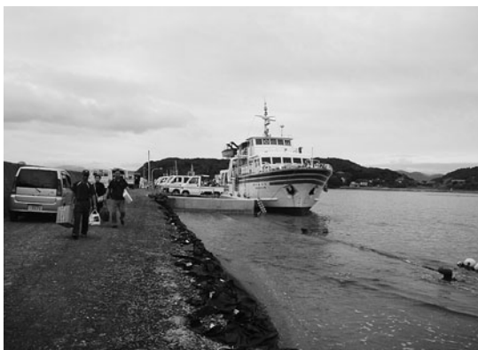
防波堤の一部を底上げし、船が着岸できるようになった網地漁港。
