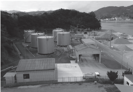
隠岐諸島の石油製品の流通を担う隠岐の島油槽所。
