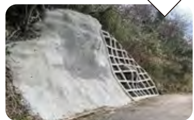
▲落石除去と法面吹付
