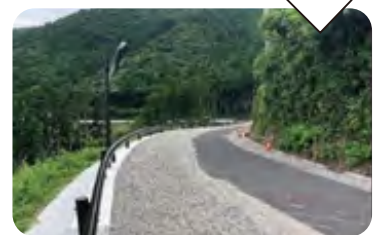
▲道路拡幅とガードレール設置
