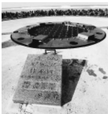
沖ノ鳥島・東小島を覆う チタン製カバーと一等三角点。
