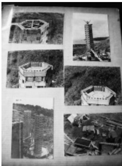
ブロックの向きを変えたり、六角形に組んでみたりと試行錯誤した様子が見られる（阪本さんのアルバムより）。
