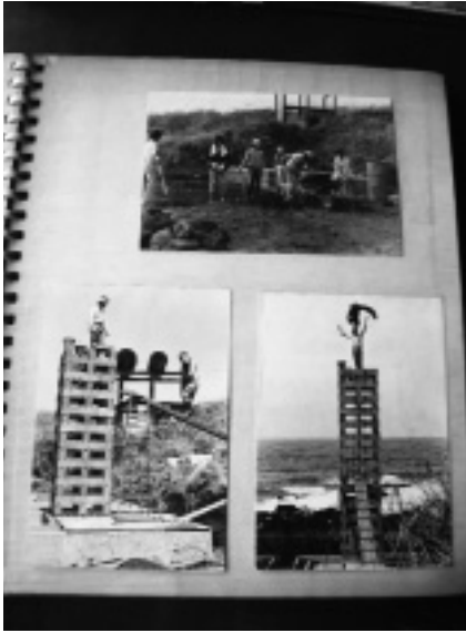
右下の写真が大島で初めて建てたかん水装置、ブロックのタワー。タワーの上に乗っているのは若き日の阪本さん（阪本さんのアルバムより）。
