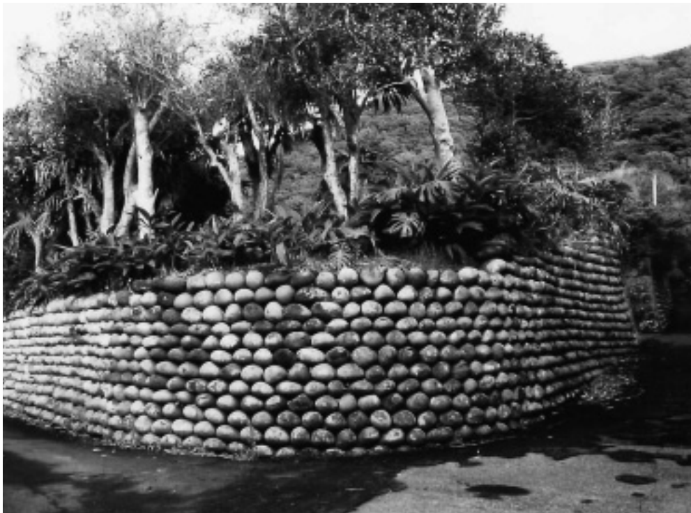
玉石垣のある道（八丈島）。
