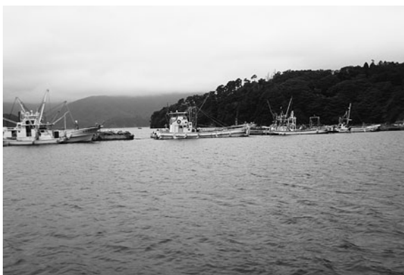
図 17 浮防波堤に係留する残存した漁船（出島漁港）。
