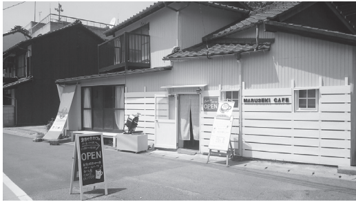
古民家を再生した「まるせきカフェ」。
