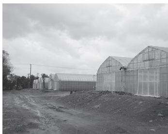
新設した耐風強化型パイプハウス。
