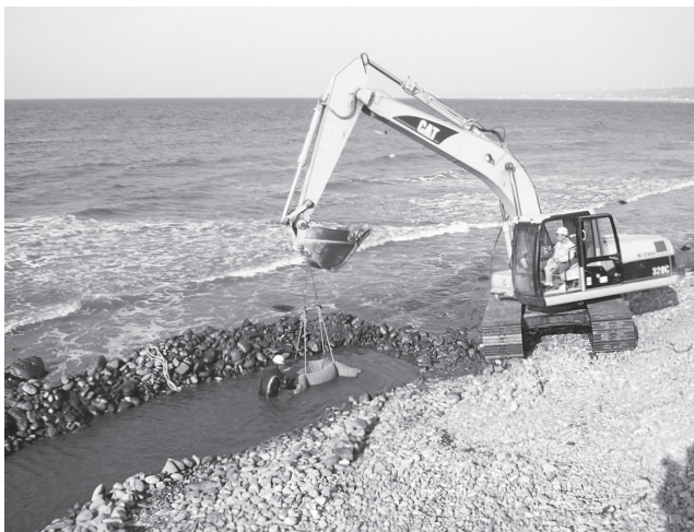
図2 鉄分供給ユニットの設置方法（註6）
