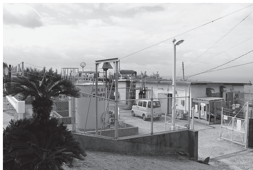
悪石島（鹿児島県十島村）の発電所。九州電力から委託を受けた住民が3交代制で管理している。
