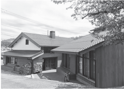
平成27年に古民家を増改築して整備された「隠岐國学習センター」の新学舎。
