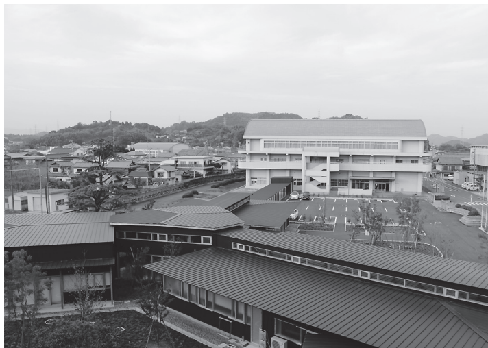
平成26年に校舎が新しくなった大崎海星高校。 建物内部は木目調の開放的な空間が広がる。
