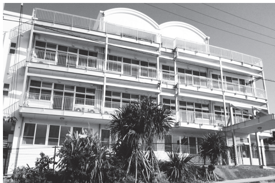
平成28年4月に完成した「じんぶん館」。久米島学習センター（町営塾）と離島留学生が暮らす町営寮が併設されている。
