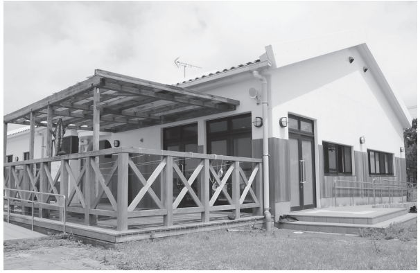
海辺にあるFactory 333の工房。
