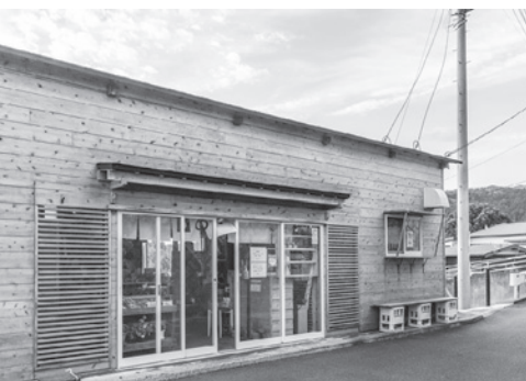
高林商店の外観。2019年の台風で大きな被害を受けた建物を改修し、翌20年にオープン。
