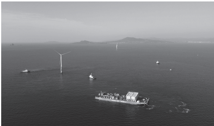
五島市の浮体式洋上風力発電施設。
