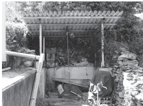
地下水位と地下水温の定点観測を実施した唐櫃岡地区の共用井戸。
