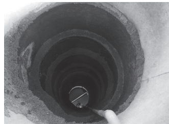
井戸の内部構造。上が石積み井戸で下が側付き井戸。
